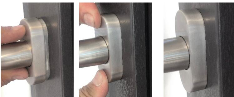
Abdeckung auf die Unterkonstruktion drücken und somit festclipsen.
