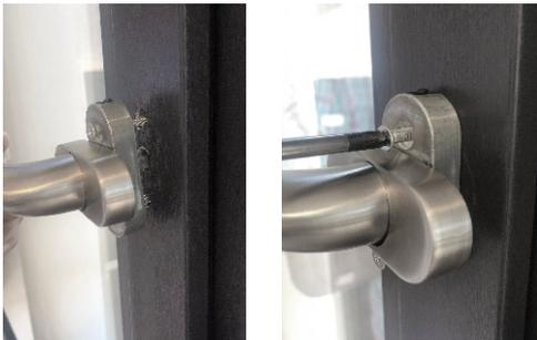
Schrauben in die Fenstergriff-Unterkonstruktion einführen und den Fenstergriff auf den Fensterrahmen aufstecken. Anschließend kann der Griff mit den Schrauben in geeigneter Länge handfest angeschraubt werden.
